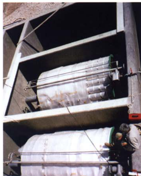
Z montáže filtrů na ČOV v Řecku
