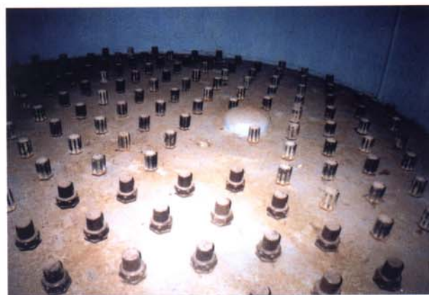
Vnitřní vestavba pískového filtru PFZ
