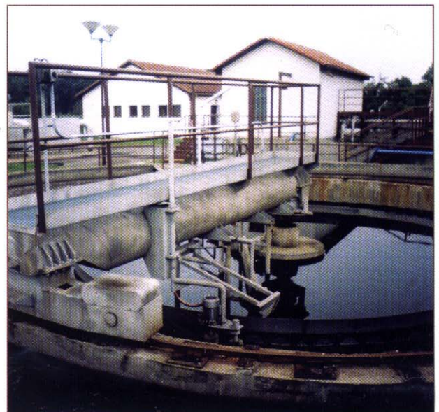
Detail dosazovací nádrže
